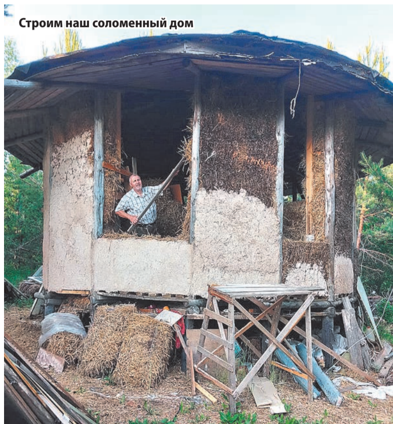
Общий дом из соломы с тростниковой крышей в ПРП Светлое, Татарстан
